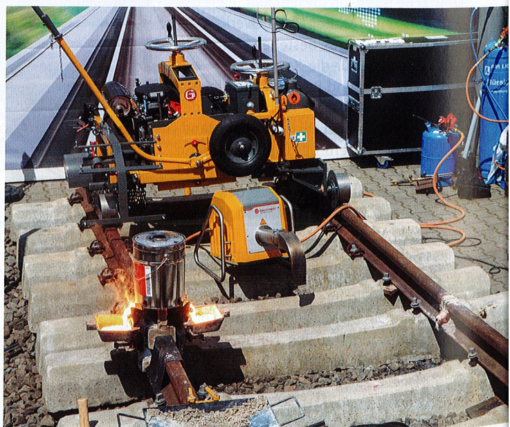
Demonstration einer Thermit-Schweißung auf der iaf 2017
