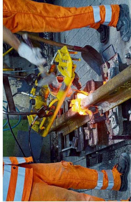
So sieht es aus, wenn zwei Schienen miteinander verschweißt werden. Sobald das glühend heiße Eisen in die Lücke gedrückt ist, werden die Schienen dauerhaft verbunden. Das Pulver, das dabei entsteht, wird durch einen Staubsauger abgesaugt. Die Arbeiter kommen zum Einsatz, um die Lücke zwischen den Schienen zu füllen. Die Arbeiter kommen zum Einsatz, um die Lücke zwischen den Schienen zu füllen. Die Arbeiter kommen zum Einsatz, um die Lücke zwischen den Schienen zu füllen.
